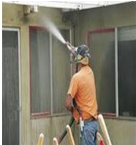
تصویر شماره ۱۶: تصاویر عملیات سندبلاستینگ
